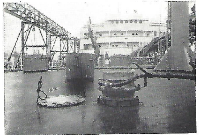
„Meco” ventilator gemonteerd op een tankdeksel.
